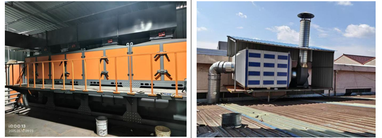
水喷淋+除雾器+活性炭吸附-脱附-催化燃烧装置 焊烟过滤装置
